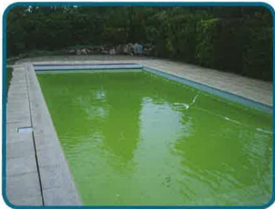
L'eau de cette piscine a été envahie par des algues vertes, du fait d'une désinfection insuffisante.
