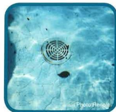
Décoloration violente de la membrane, au voisinage de la bonde de fond, dûe à un fort excès de chlore. L'oxydation des pigments s'est également accompagnée de la formation de ridules.
