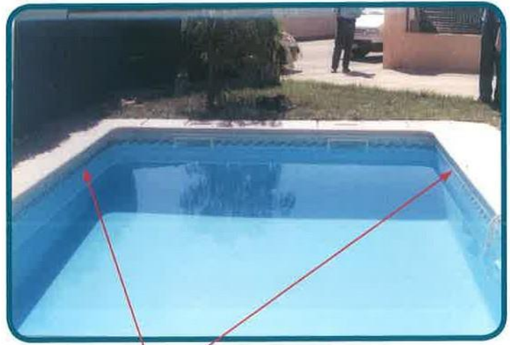
La ligne d'eau de cette piscine est plus fortement encrassée sur sa partie gauche, majoritairement exposée au soleil, que sur sa partie droite.
