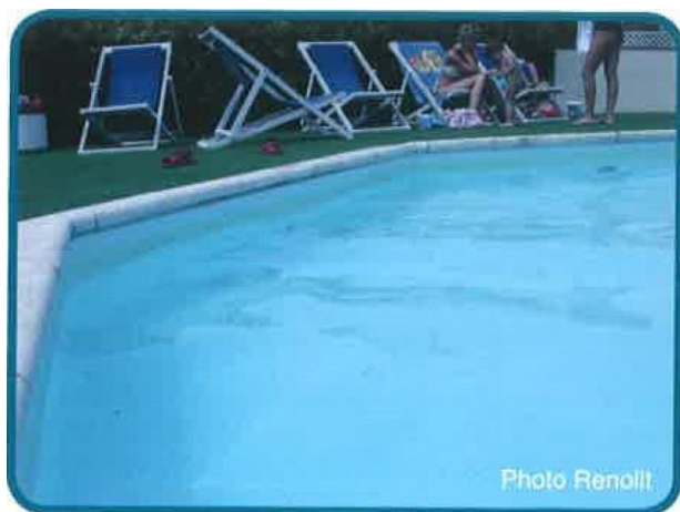
Formation de taches roses violacées, dues à la présence de bactéries ( Rectovorticillium ), entre la membrane PVC-P et le bassin.
