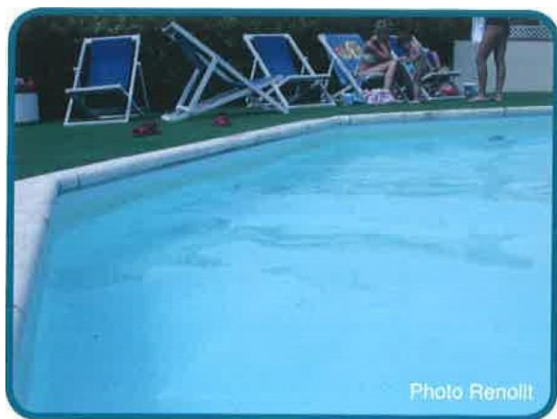
Formation de taches jaunes, à la ligne d'eau de cette piscine, dues à l'action combinée des agents anti-U. contenus dans les crèmes solaires et la présence d'ions cuivriques dans l'eau.
